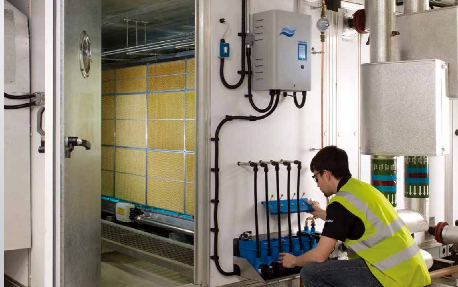
康迪ME：液压装置安装于空调机组外部
