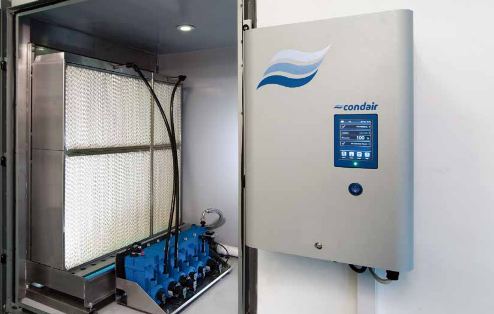
康迪ME：液压装置安装于空调机组内部
